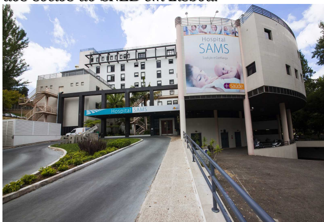
Vista frontal as instalações do Hospital-SAMS em Lisboa
